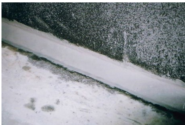
Obr. Fabion na spojení stěna – podlaha provedený z ResiBond RM.
