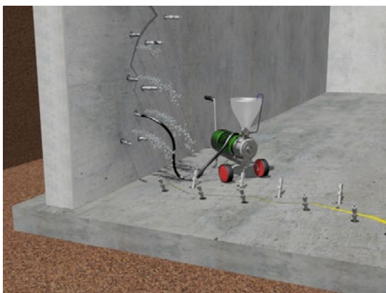
Obr.3 Tlaková injektáž průsaku v trhlíně
